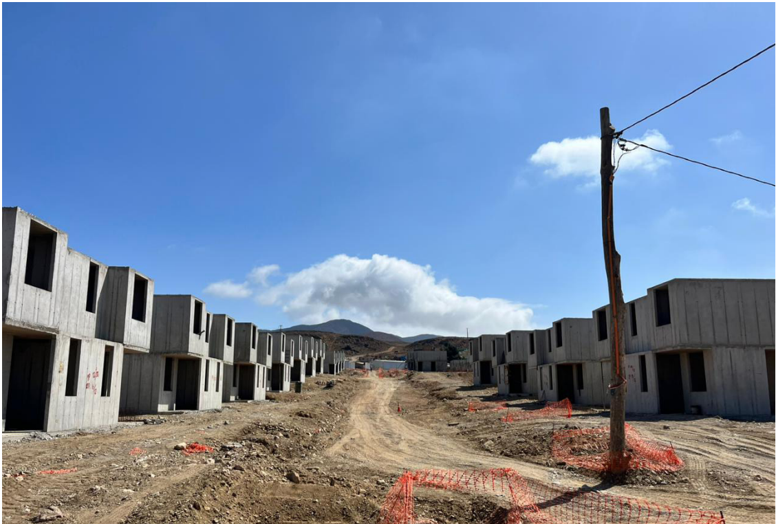
La seremi de Vivienda de Atacama, Rocío Díaz, destacó la magnitud de la obra del Plan de Emergencia Habitacional y su ejecución de acuerdo con los plazos establecidos. FOTO: MINVU
