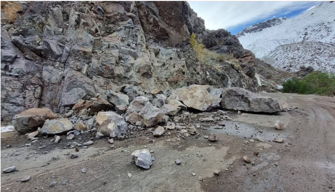
En diversos puntos de la provincia del Huasco hubo rodados en las rutas, lo que impidió el normal tránsito y que cuadrillas de trabajadores debiesen comenzar con labores de limpieza y retiro de escombros.
