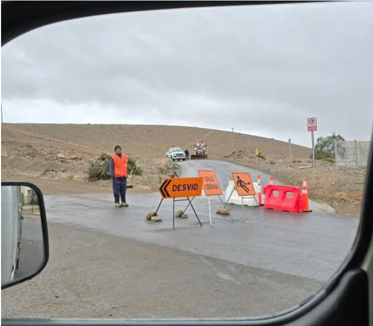
El acceso a Vista Alegre colapsó.
