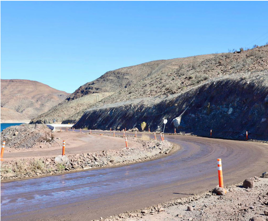
La intervención, ejecutada por la Dirección de Vialidad del MOP Atacama, busca asegurar la conectividad y mejorar la seguridad vial en el sector del embalse Santa Juana.
