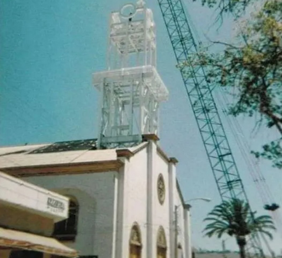
Los trabajos con grúa para instalar la torre en la iglesia. 1984
