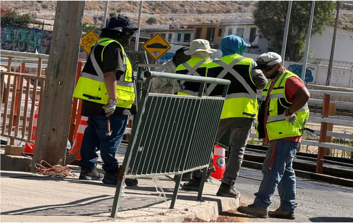
Se descartó un riesgo de colapso del puente, señalando que los daños existentes se concentran en la carpeta de rodado y en los tableros, y no en los cimientos de la estructura.
