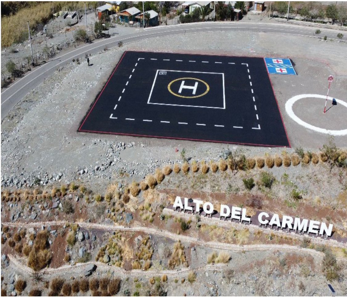
La nueva plataforma permitirá el aterrizaje y despegue seguro de aeronaves para transporte, apoyo ante emergencias, evacuaciones médicas y operaciones de seguridad, reduciendo tiempos de respuesta y ampliando las capacidades operativas en una zona de alta complejidad geográfica.
