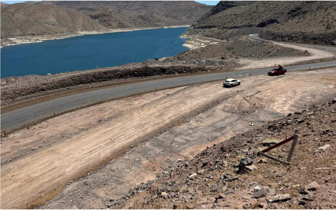
La dirección regional de Vialidad Atacama se encuentra realizando en el sector del embalse Santa Juana un estudio de ingeniería orientado a monitorear el comportamiento del terreno.
