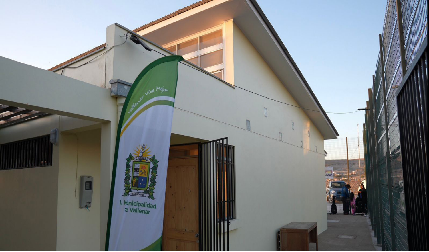
El proyecto fue financiado con el Fondo Regional de Iniciativa Local (FRIL) con una inversión de $190 millones. Las obras incluyeron la reposición de la cancha, pintura, implementación deportiva, construcción de cierres perimetrales, mejoramiento de la techumbre, habilitación de oficinas en la sede, iluminación.
