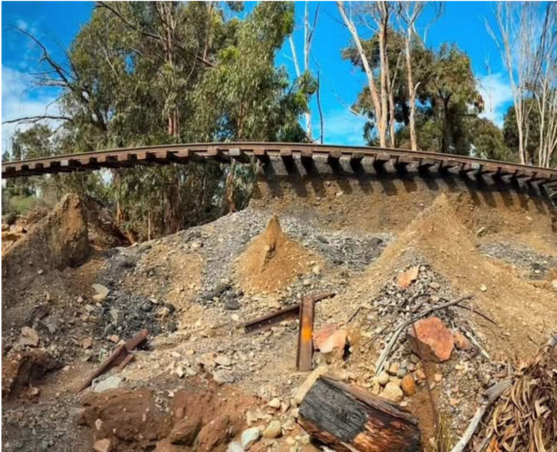
La recuperación de la conexión ferroviaria permitió avanzar progresivamente hacia la normalización de los despachos desde el Valle del Huasco.
