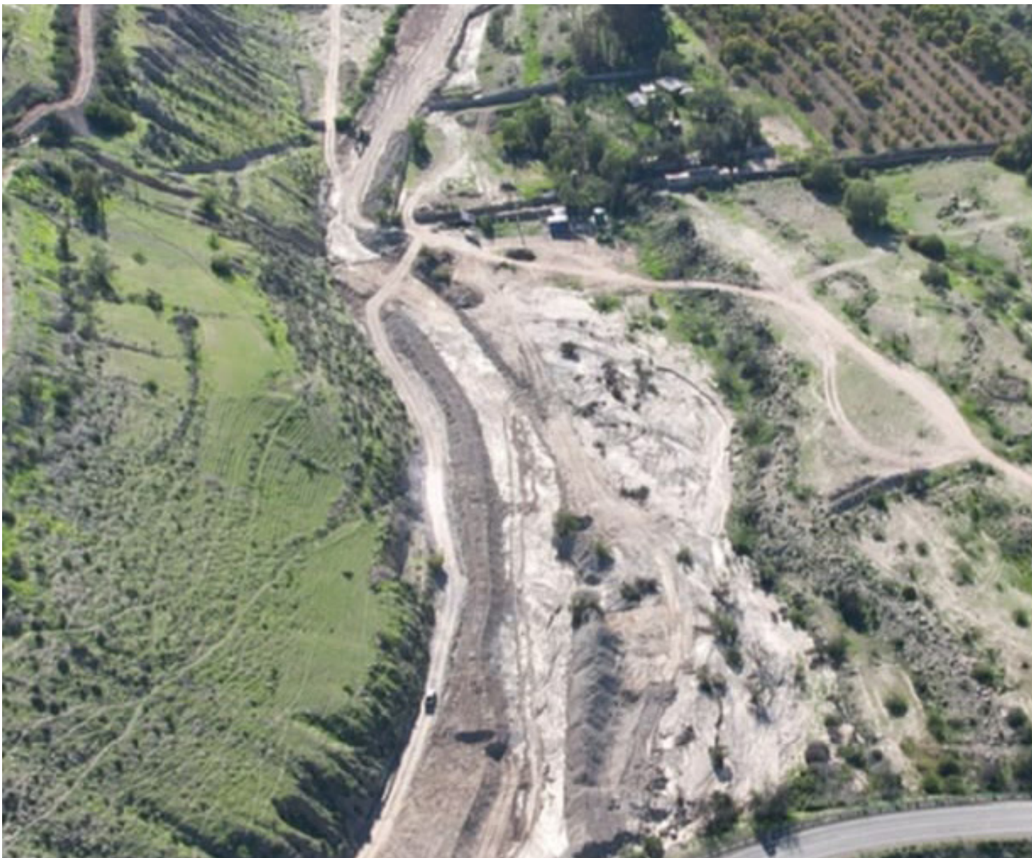
La intervención, financiada con $65 millones de emergencia aportados por el Gobierno Regional, permitió retirar material acumulado por el aluvión y restituir el encauzamiento de la quebrada desde la Ruta C-485.
