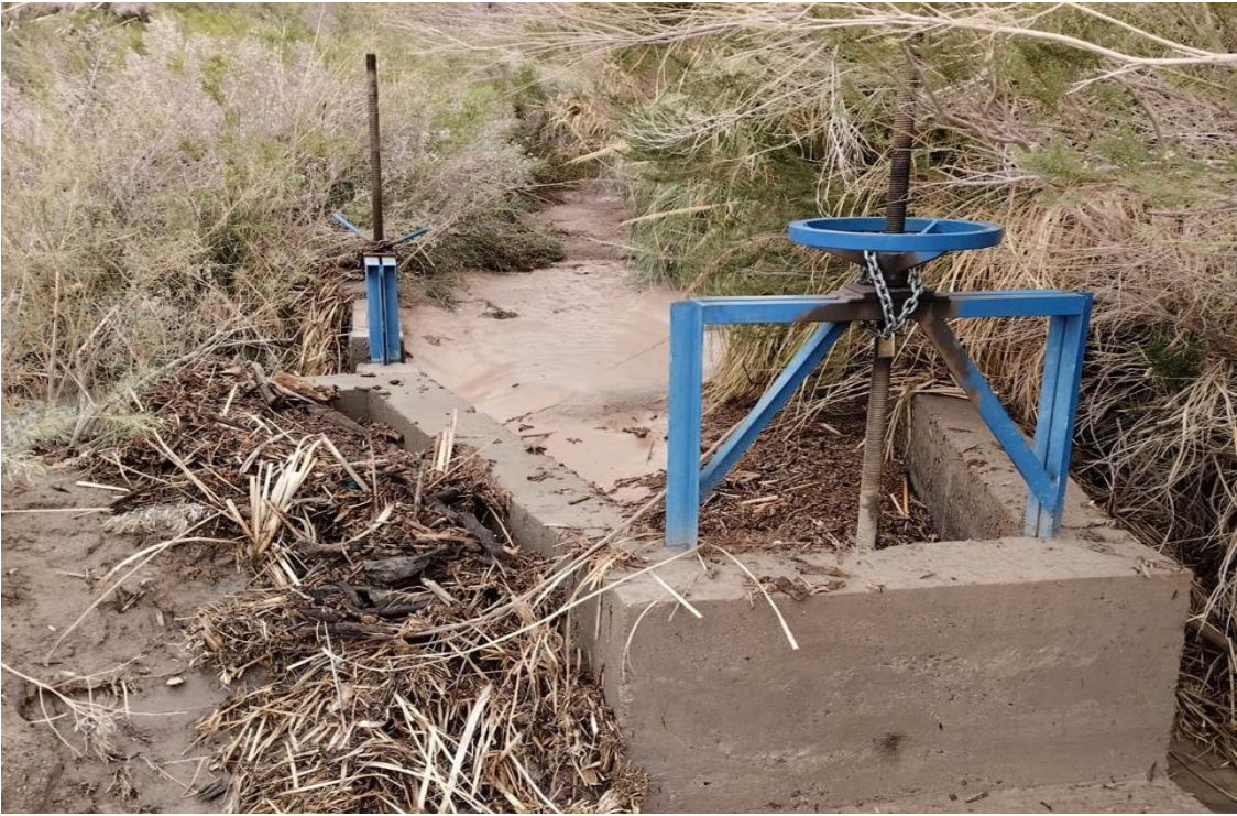
La inversión, permitirá avanzar en la recuperación total de los canales de regadío afectados por el sistema frontal, fortaleciendo la infraestructura hídrica y apoyando la recuperación de la actividad agrícola en la provincia del Huasco
