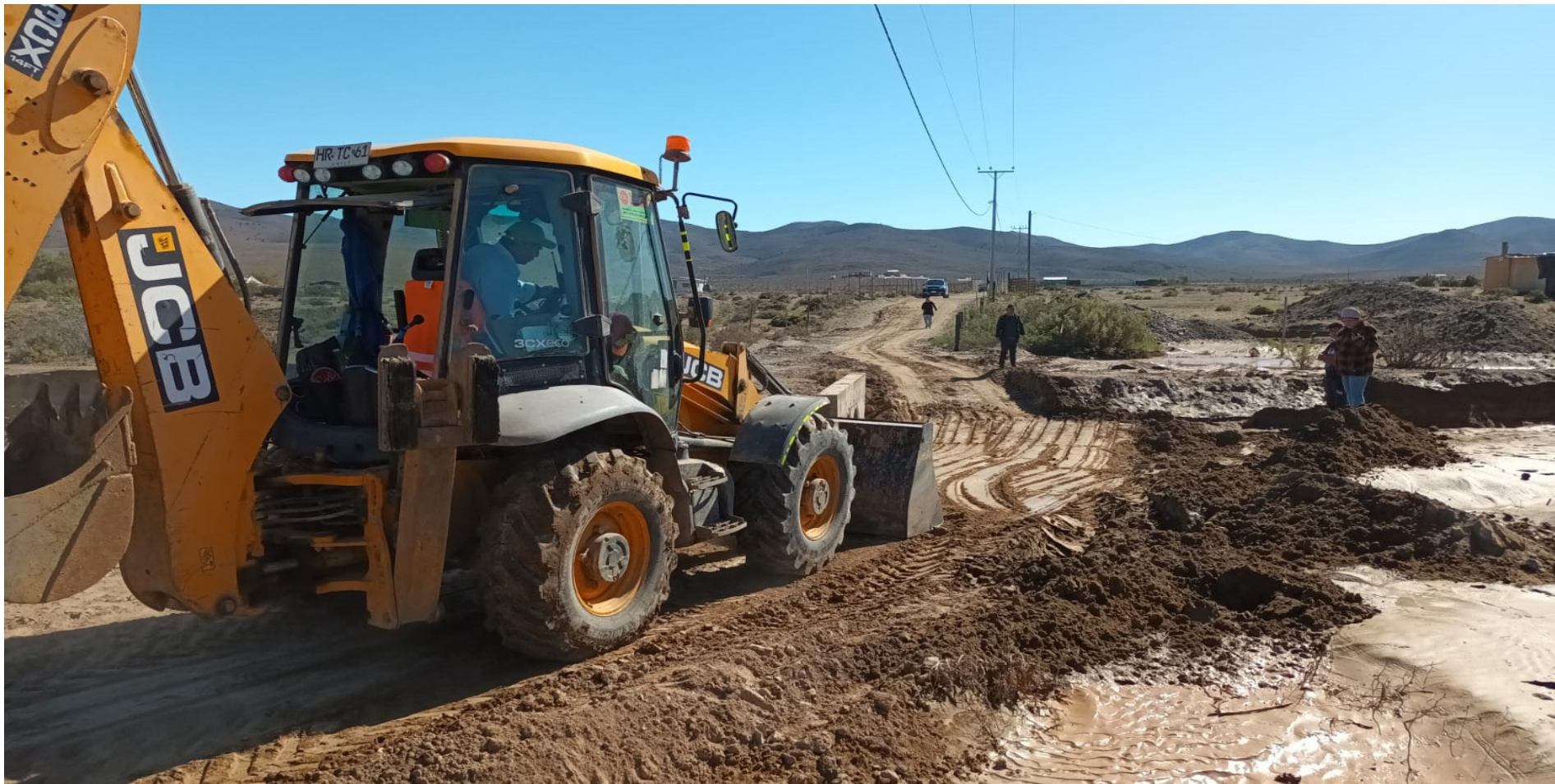
Maquinarias trabajando para despejar caminos.
