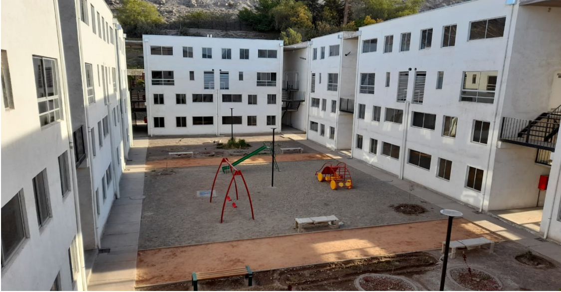
Se espera que la situación de la luz eléctrica que CGE demora 30 días en regularizar en este tipo de proyectos, será finalizada en 7 días / FOTO: ARCHIVO
