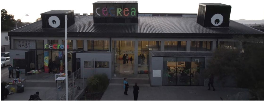
De los 14 Centros operativos, cuatro de ellos son de grandes dimensiones, y los 10 restantes, de menor tamaño e itinerantes. Durante los próximos años, se espera la construcción y habilitación de nuevas infraestructuras, para las ciudades de Arica, Coquimbo y Pichidegua.
