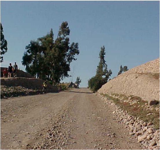
CAMINO A SECTOR CAVANCHA
